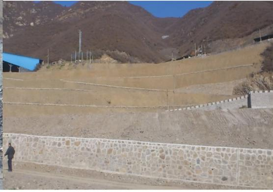
图5-9 整治后修建的挡土墙
